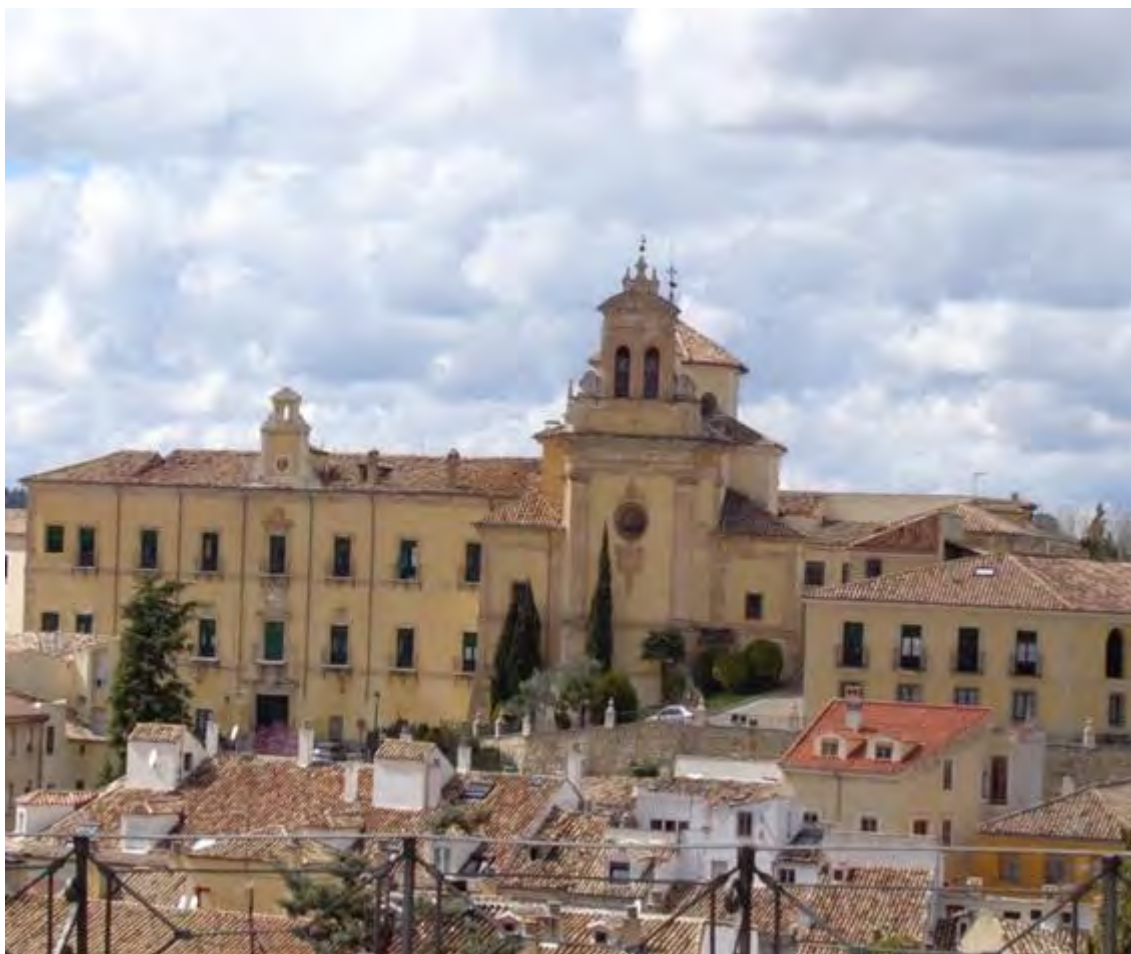
Figura 2. Estado actual de la fachada principal del hospital con la iglesia (foto cortesía de Montserrat Pérez Pinar)
